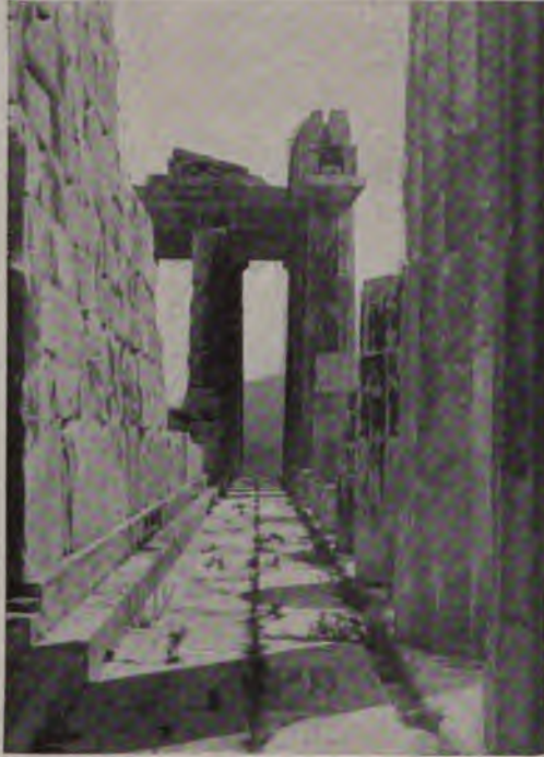
41. Das südliche Peristyl des Parthenon zu Athen nach Osten zu.
